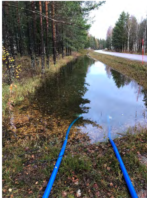
Dagvatten vid byggarbetsplats, Foto Hanna Andersson
