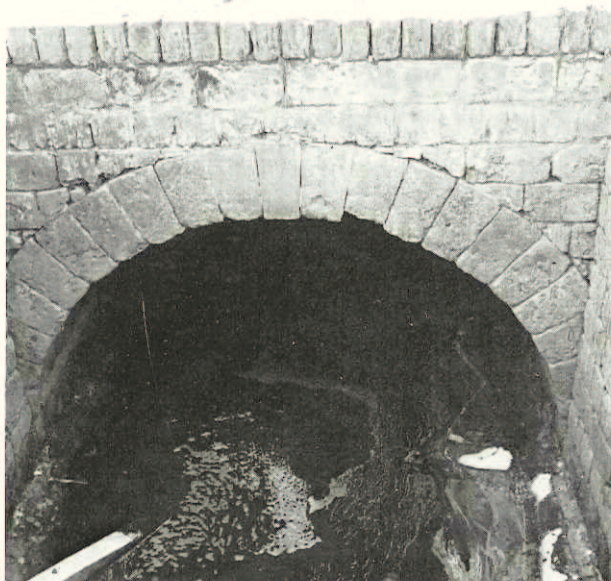
Kulvetering av Kanalen med slaggsten. På stenen i hjässan är årtalet 1879 inbugget.
