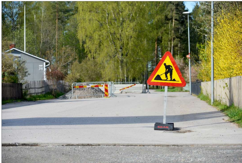
Figur: Schaktarbete på villagata (Foto: Sandviken Energi AB)
