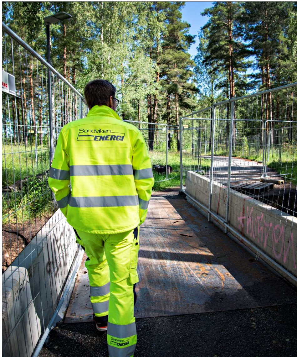
Figur: Tillfällig bro för gång- och cykeltrafik. (foto: Sandviken Energi AB)
