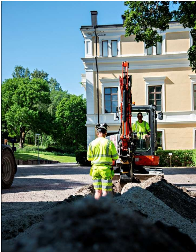
Figur: Schakt för fiber. (Foto: Sandviken Energi AB)
