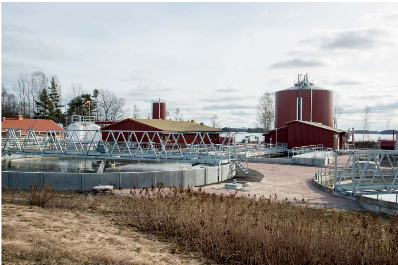
Hedåsens reningsverk är Sandvikens största reningsverk.
