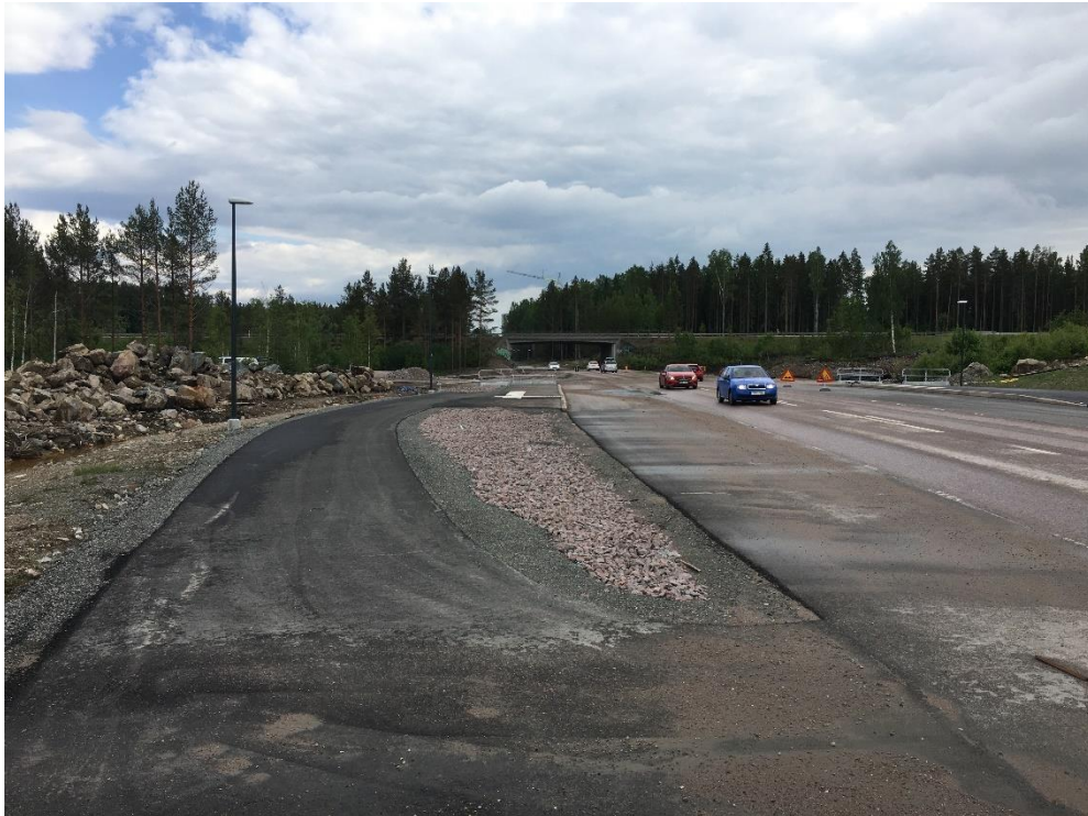
Figur 15: Bild på nya busshållplatsen på samma sida av Järbovägen som planområdet.
