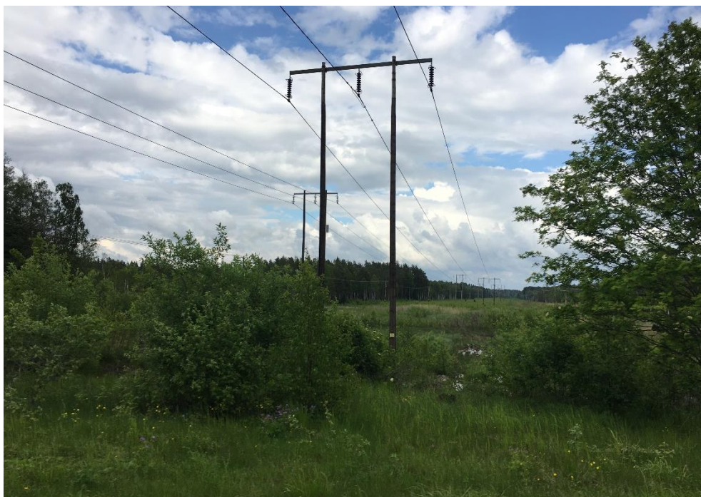
Figur 27: Bild tagen från Järbovägen på kraftledningsgatan norr om planområdet.
