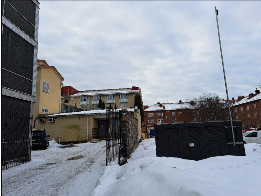
Foto över befintlig transformatorstation, mur och innergård på hotellets baksida ut mot Drottningtorget och Stadshuset.
